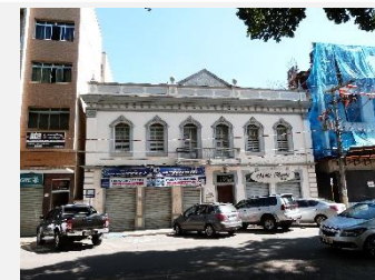
Categoria: Bens Imóveis / Estruturas Arquitetônicas Denominação: Residência e Comércio nº28 Localidade: Praça 28 de setembro Área: Distrito Sede- Área 2
