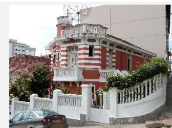
BI 17 Categoria: Bens Imóveis / Estruturas Arquitetônicas Denominação: Residência “A voz do Rio Branco” nº167 Localidade: Rua Governador Benedito Valadares Área: Distrito Sede- Área 2
